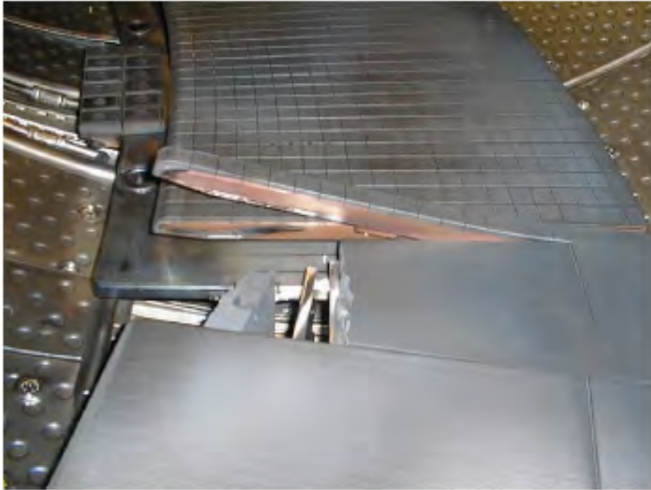
Figure 2.18 – Exemple de déformation engendrée par des courants induits : aiguille tordue d'un limiteur de Tore Supra, plaque de CFC cassée
